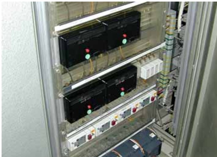
Bild 1 Der alte Zustand
