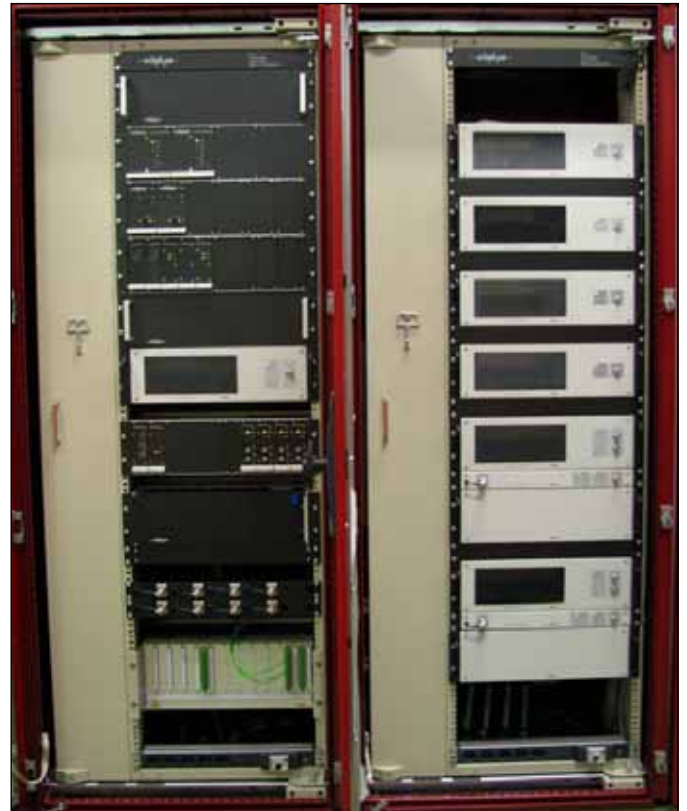
Bild 3 Ausrüstung in den Tunnel-Abschnitten
